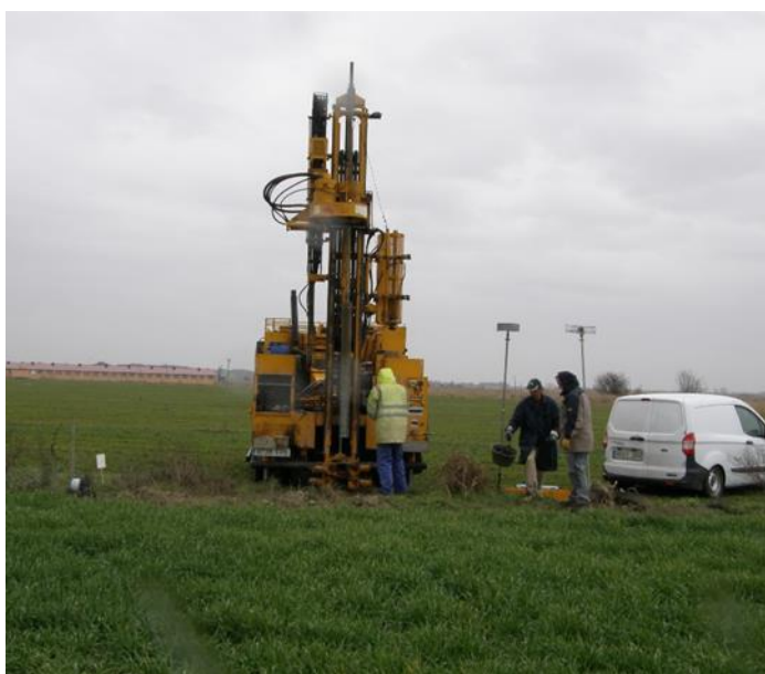
Figura 6. Perforación de sondeos para el estudio y control de los retornos de riego de la CR de Almodévar, Huesca (izquierda). Testigo continuo de un sondeo (derecha).
