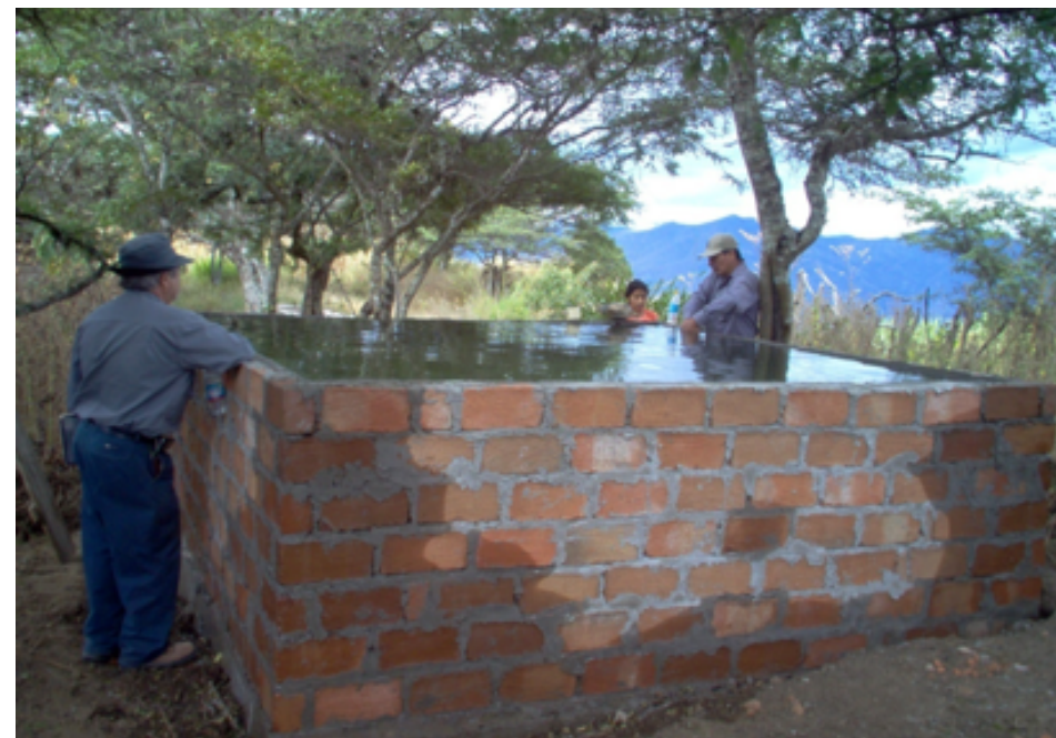
Foto 7. Pilancón elevado de ladrillo y cemento para producir riego por aspersión.
