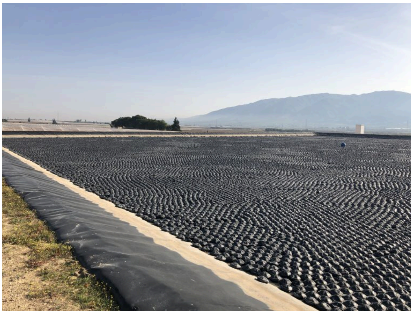
Cobertura flotante modular para mitigar las pérdidas por evaporación en balsas.
