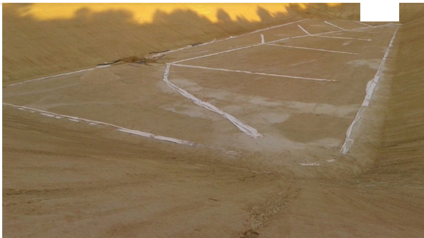
Dren de cintura y red ramificado para el control de fugas en los taludes.
